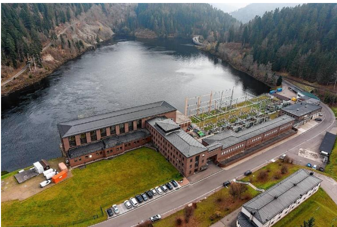
Das Kraftwerk Häusern ist das erste Kraftwerk der Schluchseewerk AG (Bauzeit 1929 bis 1931)
