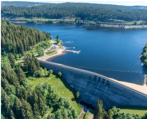
Blick auf die 63 Meter hohe Staumauer des Schluchsees
